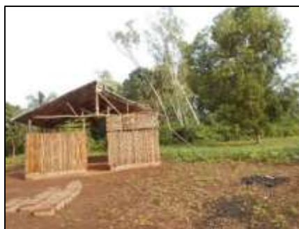
Photo 2 : Construction en cours d'une Eglise à côté d'une forêt sacrée "Egoun-zoun" dans l'Arrondissement I
