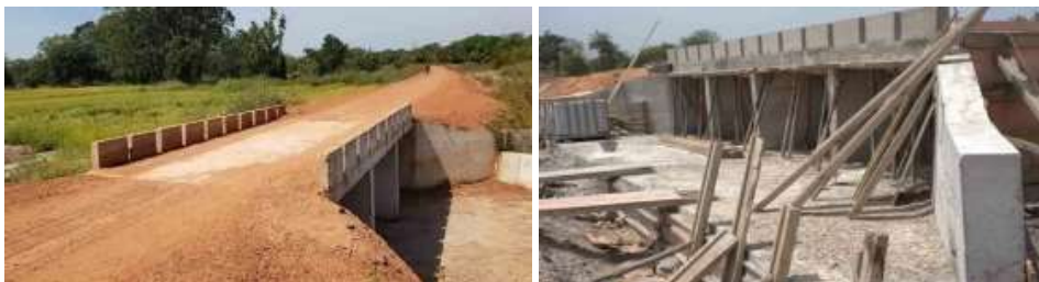
Fig.10 : La digue de Heir à Cabrousse en construction
