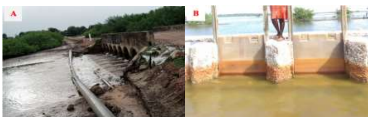
Fig.9 : Digue équipée de vannes à Loudia Diola (A) ; Mini barrage à Efoque (B)
