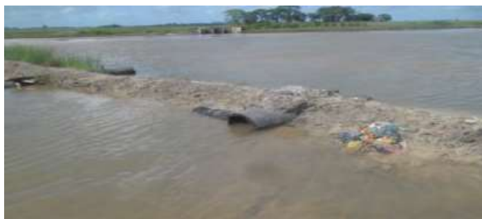
Fig,12 : Système de drainage traditionnel
